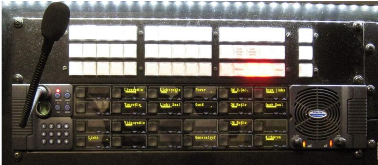
Abbildung 3: Intercom-Sprechstelle am Inspizientenpult
