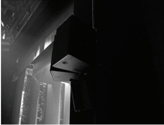
Abb. 17.28: Lautsprecher mit Splay-Winkel
