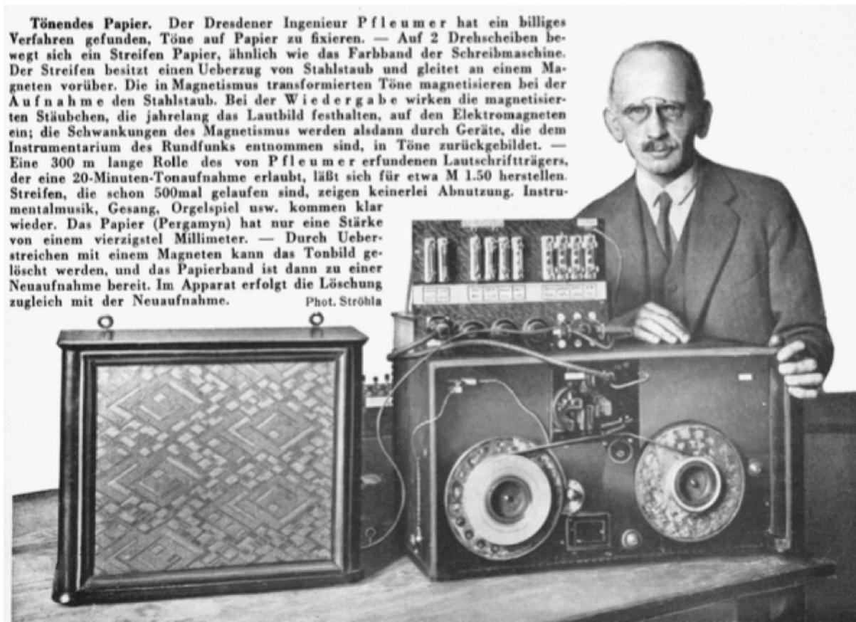
Abbildung 8: Fritz Pfeumer und das Magnetbandgerät
