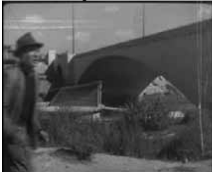
Sounddesign: Hall im Tunnel
