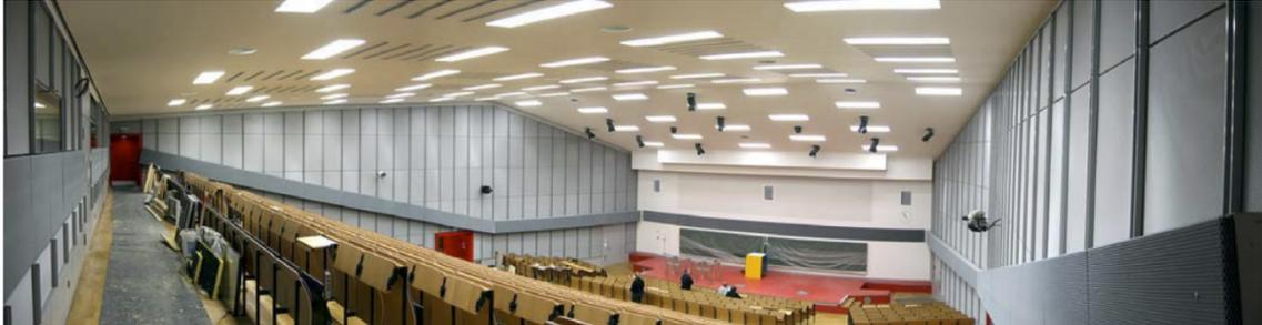
**Abb. 4.1.8:** Hörsaal H 104 der TU Berlin mit umlaufendem Lautsprecher-Array in der Bauphase.
