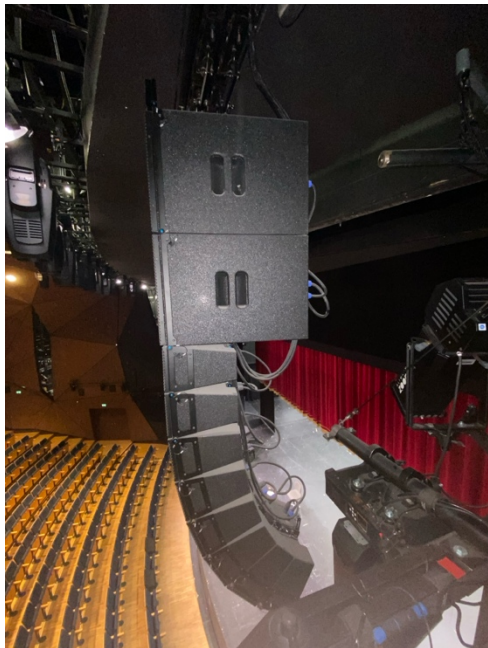
Abbildung 6: Main PA rechts aus 8x LR7 und 2xLR7B in Stuttgart (Quelle: Eigenes Foto)
