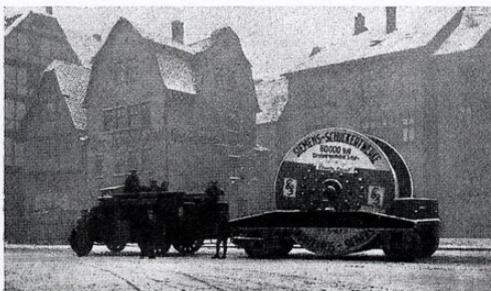
Bild 12. 60000 V-Kabel auf dem Transport.
